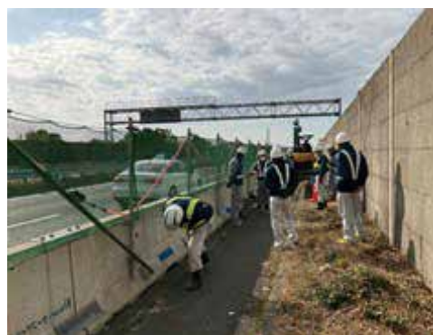
現場巡視状況
