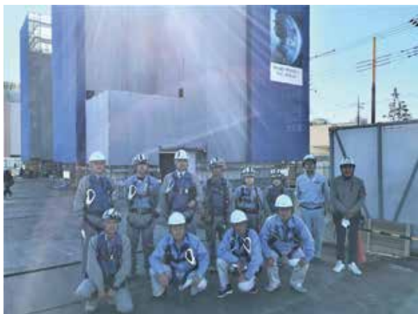
<建築>フジパン下妻2作業所（整列）
