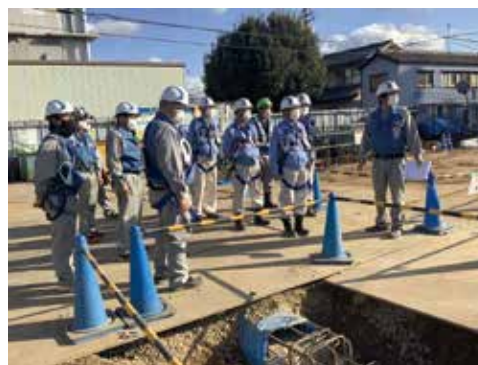
現場巡視状況
