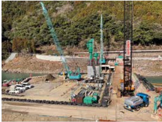
工事ヤード全景
