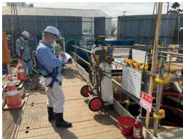
<土木>防衛厚木推進作業所（現場巡視）
